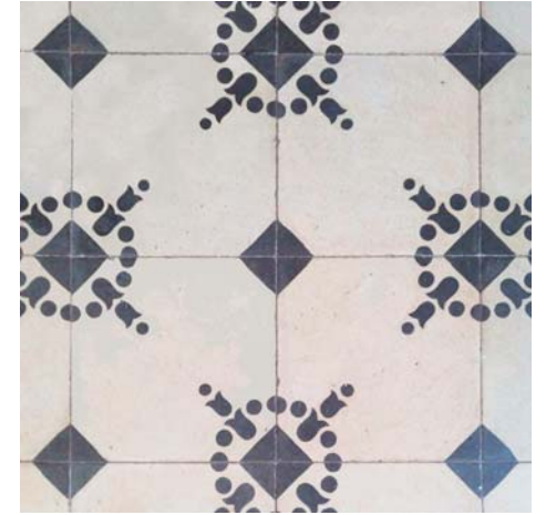
PAVIMENTO HIDRUALICO RECUPERADO
