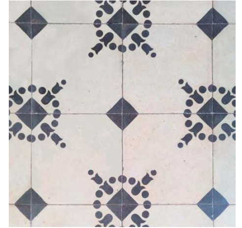
PAVIMENTO HIDRUALICO RECUPERADO
